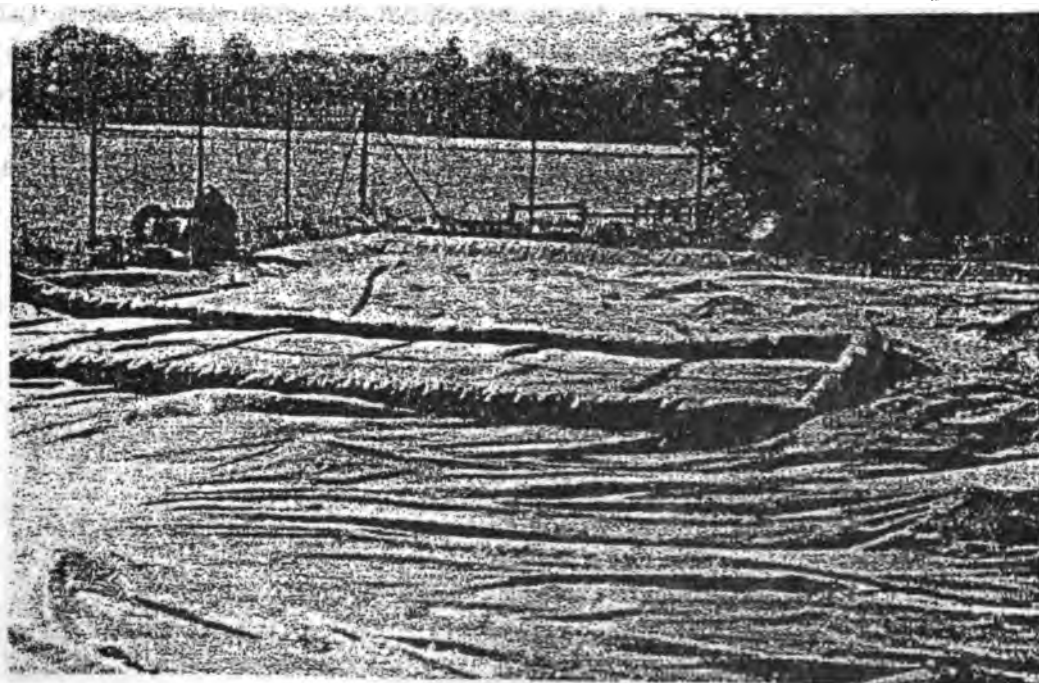
FIGURA 8: ESTANQUE CON CUBIERTA FLOTANTE DE MATERIAL PLASTICO/2/
