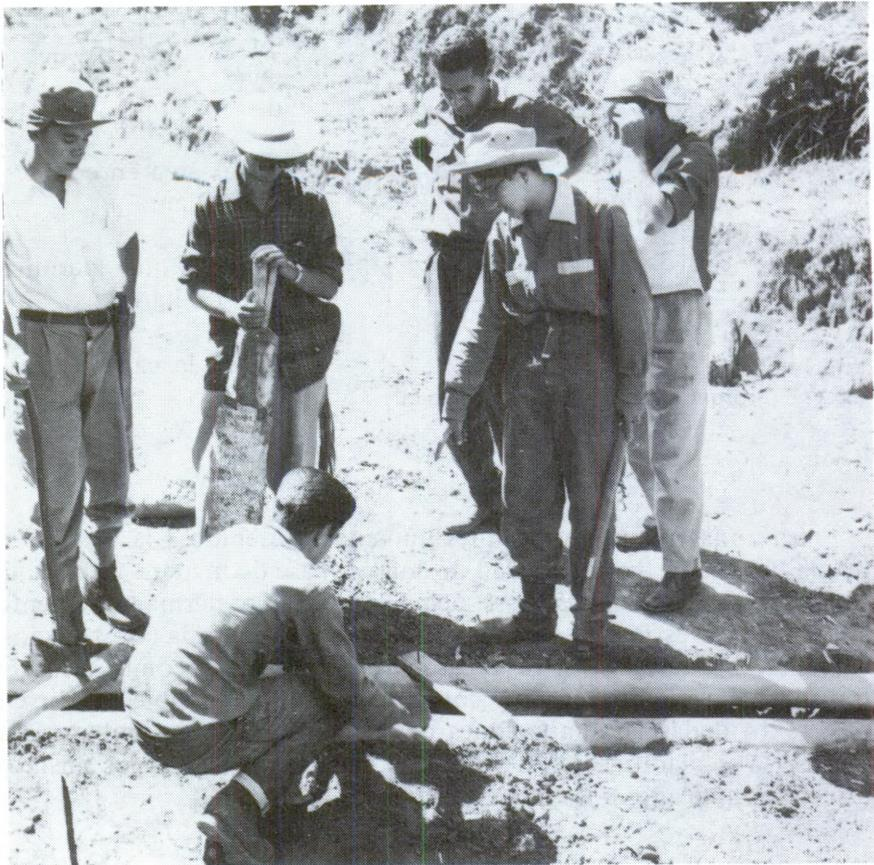
Fig. 37. Detalle de construcción de drenaje transversal en caminos forestales.
