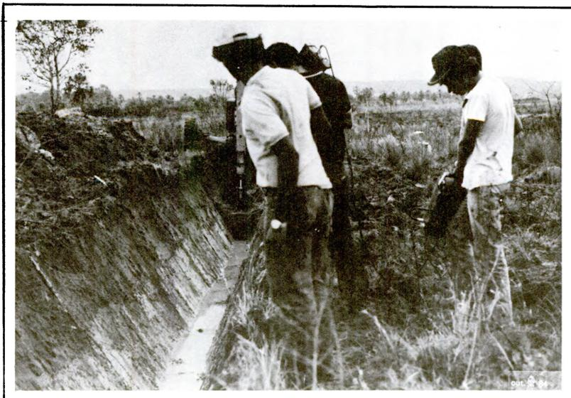
*Construção do dreno coletor no Setor III. Observe o solo superficial orgânico úmido, com vegetação natural de brejo.*
