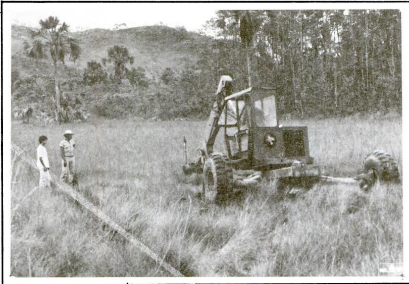
*Construção do dreno no setor final, antes do Ribeirão Mestre d'Armas. Trata-se de um dreno de escoamento.*
