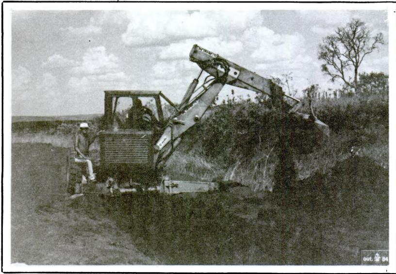
*Construção do canal de captação C1. Em vista da grande seção transversal necessária para comportar a vazão de 300 l/s e da construção do canal todo em corte, foi preciso utilizar a Kamo.*
