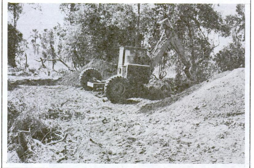
*Outro aspecto da construção da barragem nova. Ao lado, a retirada do solo orgânico. Abaixo, abrindo um desvio para secar a área de trabalho, já que as águas da bacia do pequeno córrego são incessantes e o volume na vazão mínima chegava a 200 litros.*
