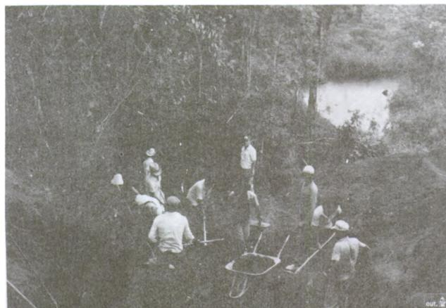
**NOVO VERTEDOURO DA BARRAGEM MAIOR – conexão entre o vertedouro e o Córrego Arrozal. Vista da escavação.**
