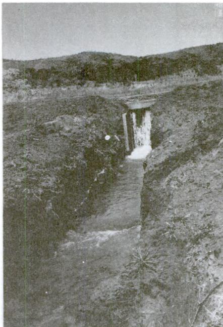
**CANAL PRINCIPAL DE CAPTAÇÃO DA BARRAGEM MAIOR** – Início do canal. Vê-se, ao fundo, a mureta de contenção e o muro de terra que reforça a mureta. Vista do teste de circulação da água.
