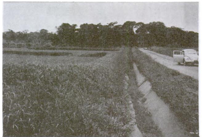
*Na foto vêem-se três obras: à direita, a estrada interna; no centro, o dreno superficial; à esquerda os campos dos tabuleiros. As ervas voltaram a nascer e crescer rapidamente porque as bordas de terra ainda não foram compactadas.*
