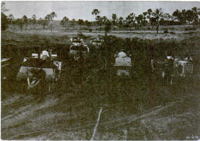
**BARRAGEM NOVA** — Acabamento da crista da barragem de contenção, de acordo com as cotas delineadas no projeto.
