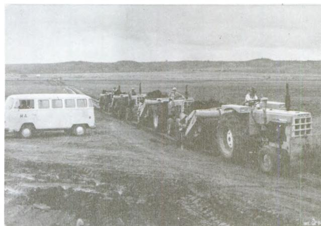
*BARRAGEM NOVA – Tratores com scrapers, da Fundação Zoobotânica, trazem material de empréstimo para a construção do maciço da barragem.*
