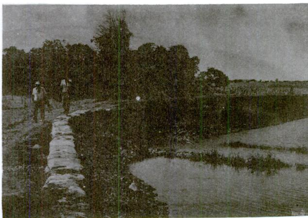
**BARRAGEM NOVA** – Barragem de contenção concluída. Observe-se, nas duas fotos, a linha de sacos cheios de terra que completam a cota máxima de um dos diques laterais, como medida de emergência para conter o nível máximo de água na época de chuva.
