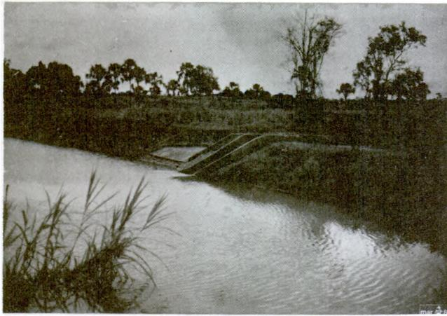
*Obras civis da barragem noya localizada na confluência dos córregos Corguinho e Arrozal. À esquerda da foto, o vertedouro feito de concreto armado, à direita, o canal de limpeza e segurança da mesma obra.*
