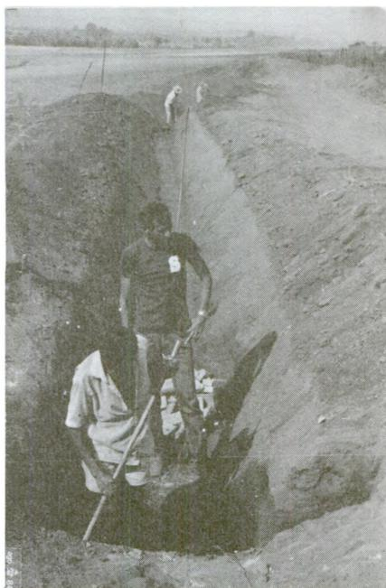
*Dr. SILAS FORNECE AS MEDIDAS DAS OBRAS AOS PEDREIROS. NESTE CASO, TRATA-SE DE UM SALTO HIDRÁULICO PARA DISSIPAR A ENERGIA HIDRÁULICA E DIMINUIR A VELOCIDADE DA ÁGUA, A FIM DE EVITAR EROSIÃO NOS CANAIS E DRENOS.*
