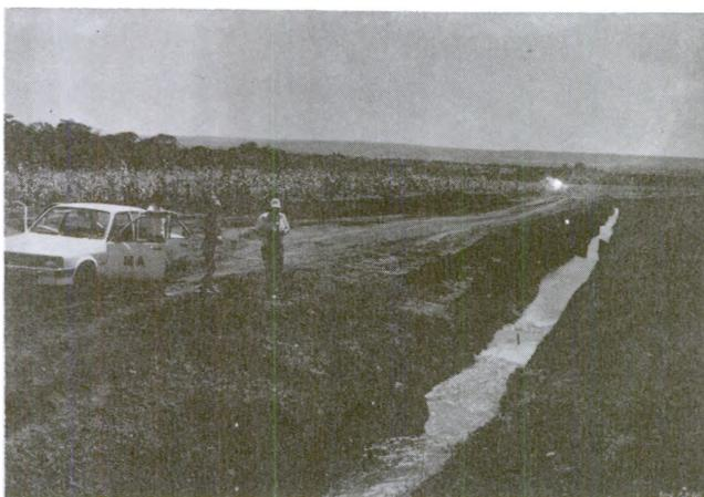
**CANAL PRINCIPAL DE CAPTAÇÃO DA BARRAGEM MAIOR** – Vista dos saltos, construídos em alvenaria, no trecho inicial. À direita, a estrada de serviço de manutenção do canal.
