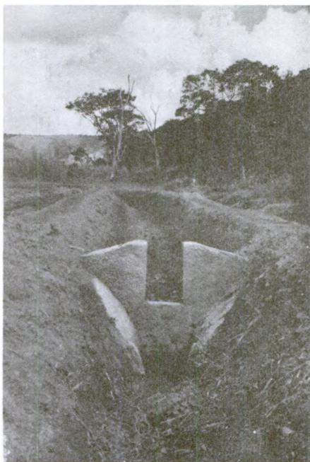
*Construção de saltos em alvenaria. Observe-se o desnível do canal na parte de cima, com declividade de 2‰ e o salto hidráulico de 50cm de altura. Em baixo, o canal continua com a mesma declividade.*
