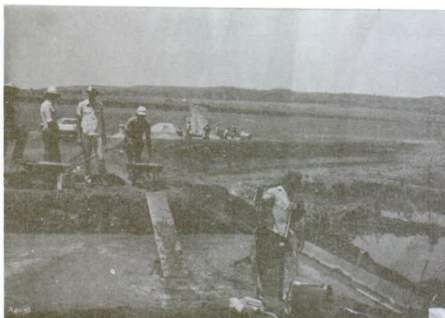
**Início da concretagem do vertedouro na barragem nova.**
