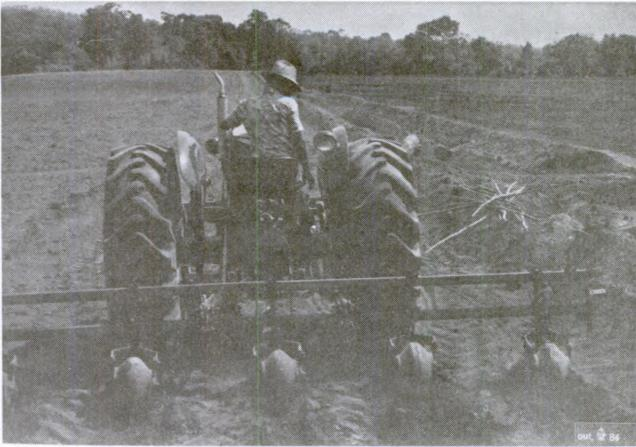
*Máquina iniciando a construção dos sulcos. À direita, um canal condutor. À esquerda, o campo nivelado para os sulcos.*
