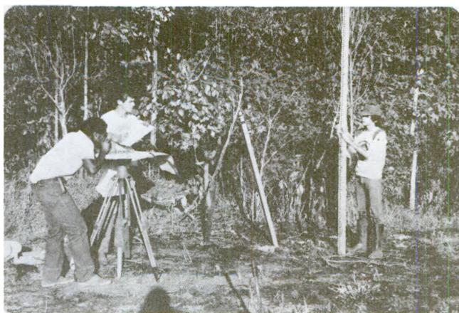
*Levantamento altimétrico do local onde seria construída a barragem na confluência dos córregos Arrozal e Corguinho.*
