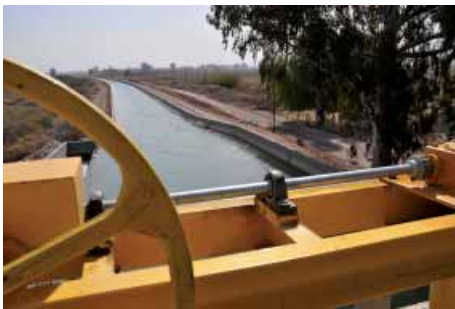
PROSAP - San Juan - Canal del Norte
