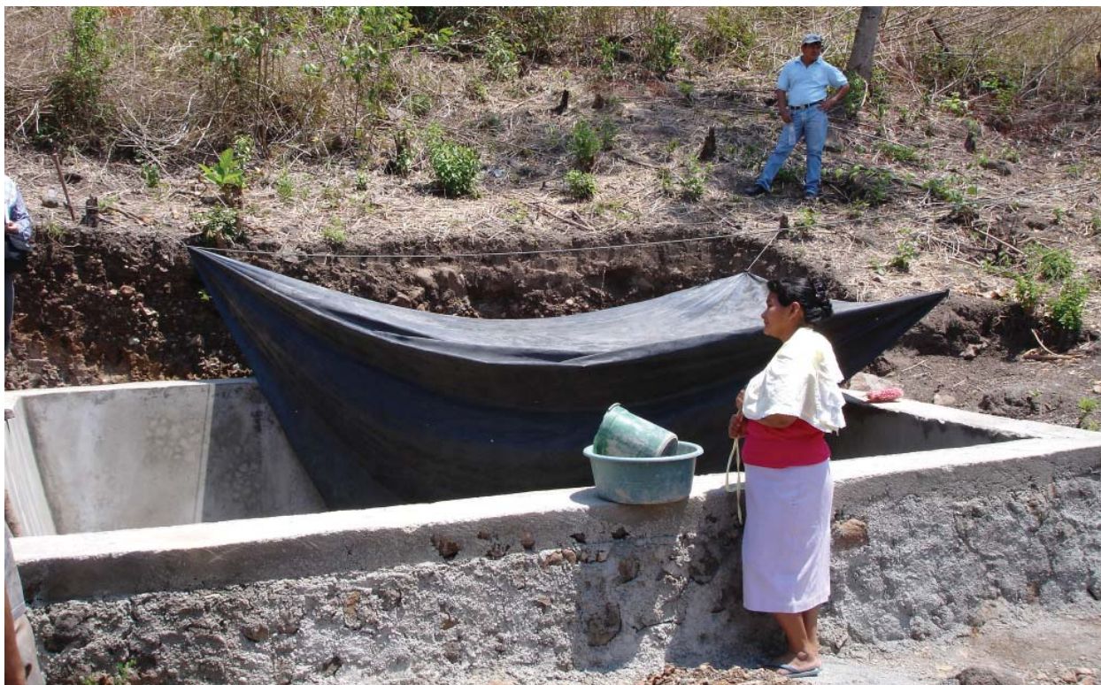
Figura 24: Construcción de pila para la cosecha de aguas lluvias destinadas al riego de cultivos de hortalizas en El Salvador.
