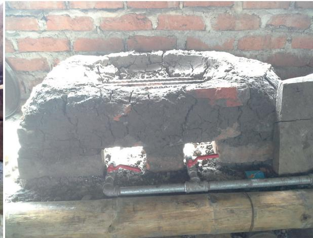
**Foto 4.** Quemador a biogás cubierto en arcilla en el centro educativo Dxi Phaden, R. de Huellas, Caloto- Cauca
