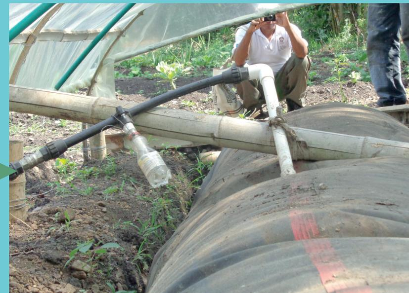
Foto 22. Tubería de salida de biogás y válvula de seguridad inclinadas. Esto no permite que el tubo de PVC este sumergido 10 cm en el agua, por tanto va haber burbujeo y escape de biogás.
