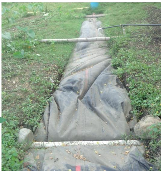
Foto 21. Biofamiliar al que no se le hicieron canales de drenaje de aguas lluvias y se "entorcho"
