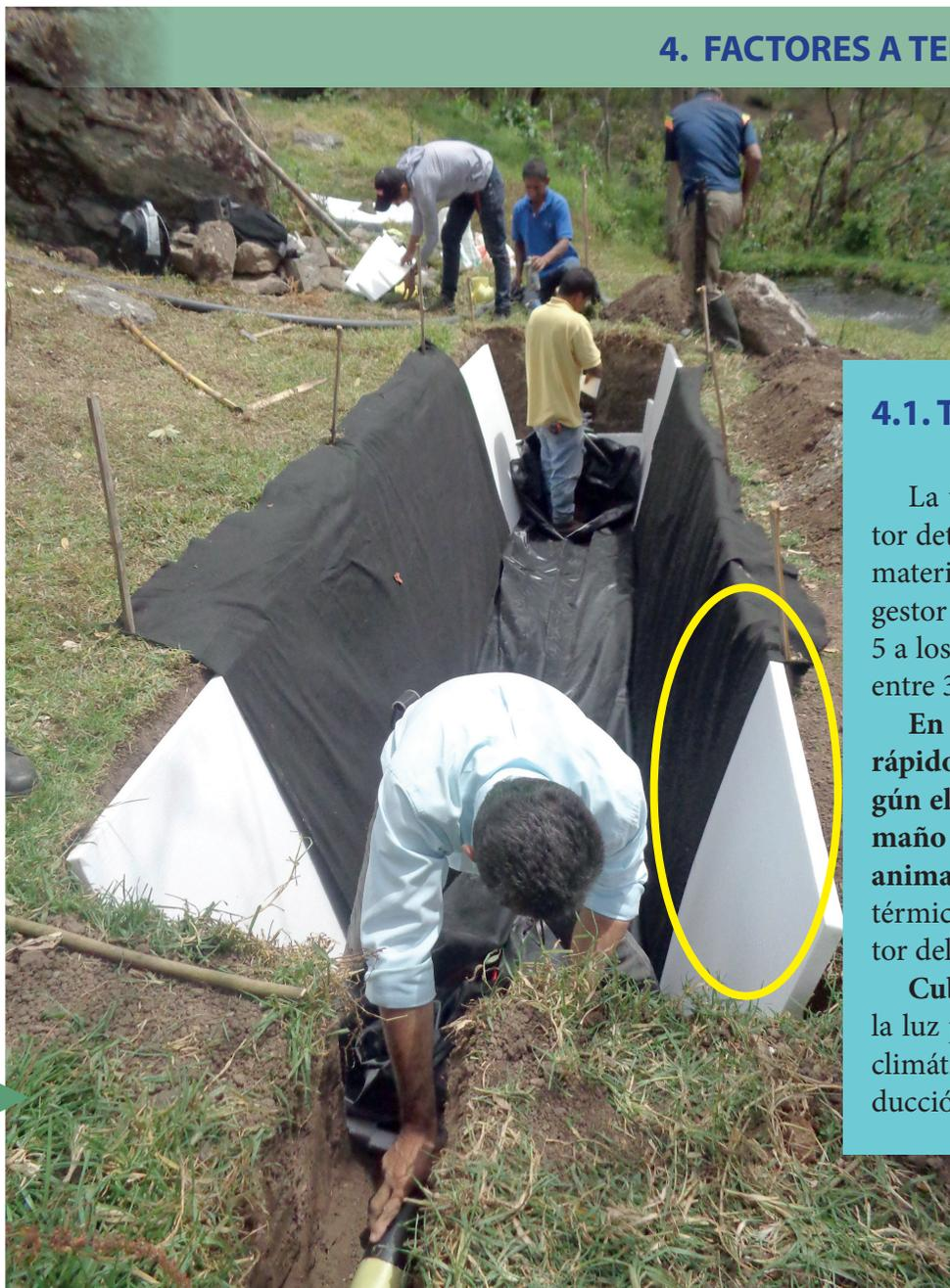
*Foto 19. Biofamiliar Sr; Guillermo Ascúé instalado con láminas de icopor como aislante. Toribio. Cauca.*
