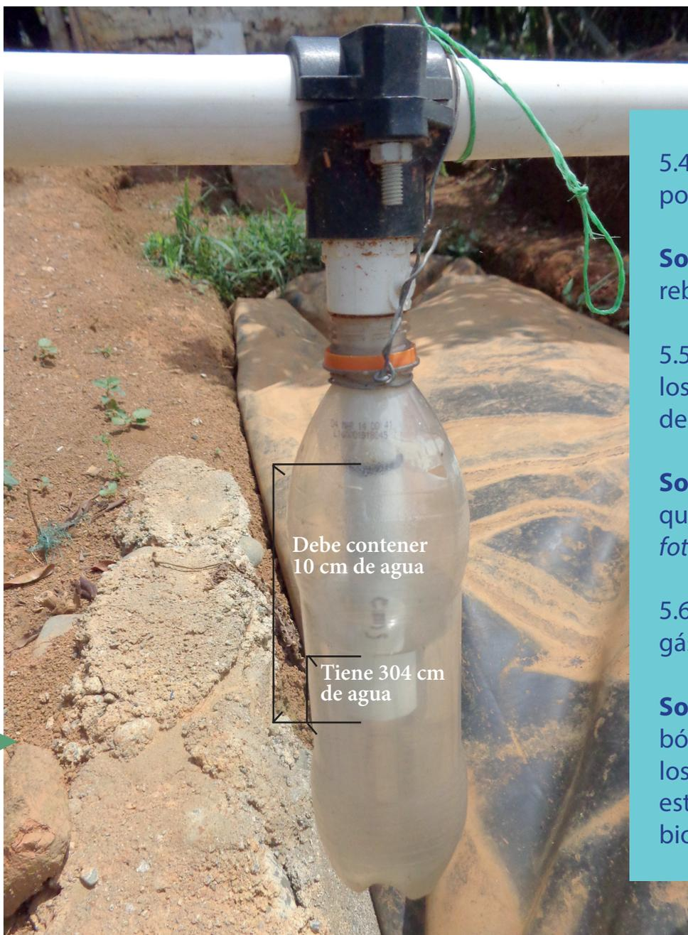
Foto 27. válvula de seguridad con menos de 10 cm de agua, escape de biogás (burbujeo)
