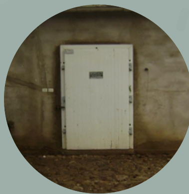
PORTÓN DE INGRESO A LA CÁMARA DE FRÍO Y PISO CON PIEDRA PARA VACIADO DE CEMENTO
