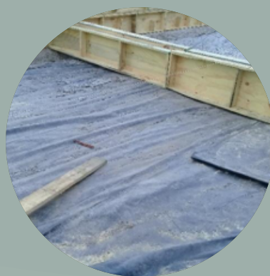
COLOCADO DE AISLAMIENTO EN EL PISO PARA CÁMARA DE FRÍO
