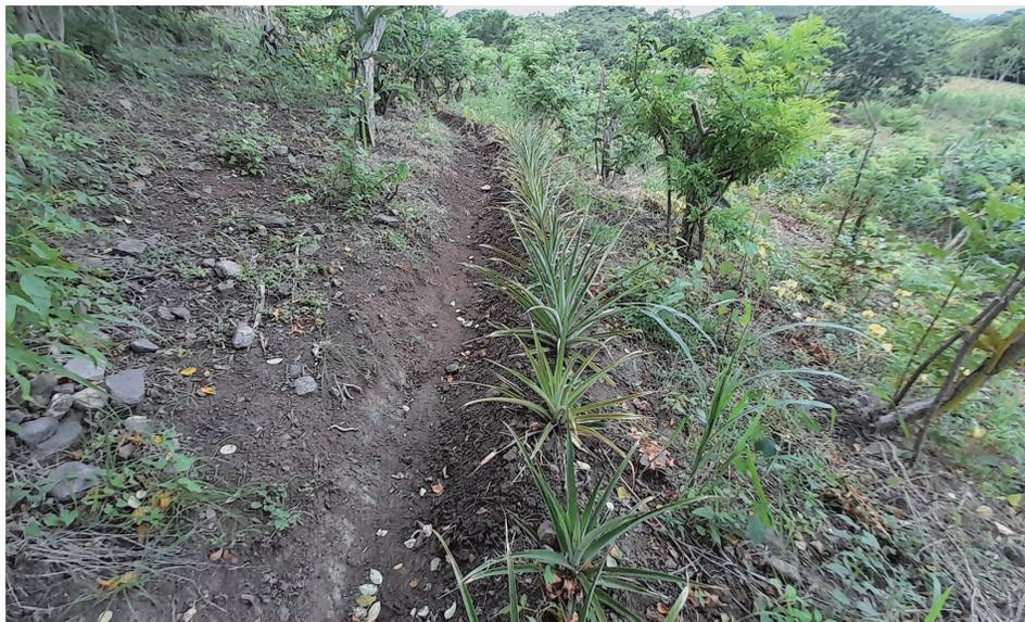
Para garantizar una larga vida útil la acequia debe ir siempre acompañada de barreras vivas sembradas en la parte superior de la obra. Estas barreras evitan que los sedimentos arrastrados por la lluvia rellenen la acequia.
