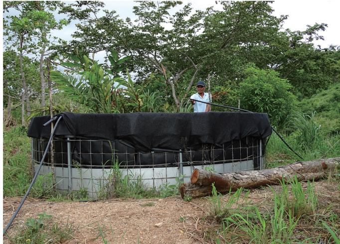
**El segundo paso** es el montaje de la estructura de soporte, esta consiste en colocar 8 tubos galvanizados de 1,20 m de altura y 1 ¼ " de diámetro, los cuales se entierran a una profundidad de 20 cm alrededor del borde del círculo delimitado
