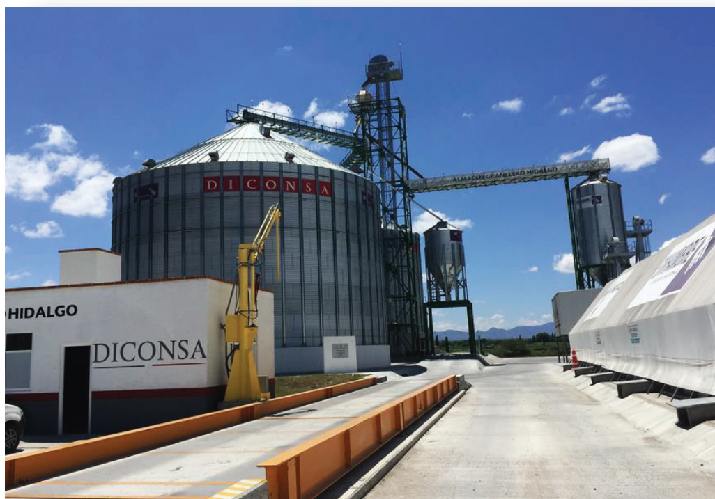
Instalaciones graneleras de DICONSA en Hidalgo
