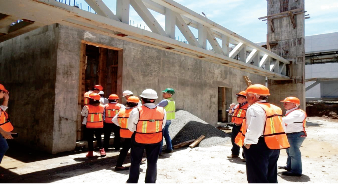
Construcción nueva planta de MOSCAMED en Chiapas
