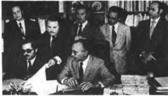
Se firman los contratos para la construcción. 1975
