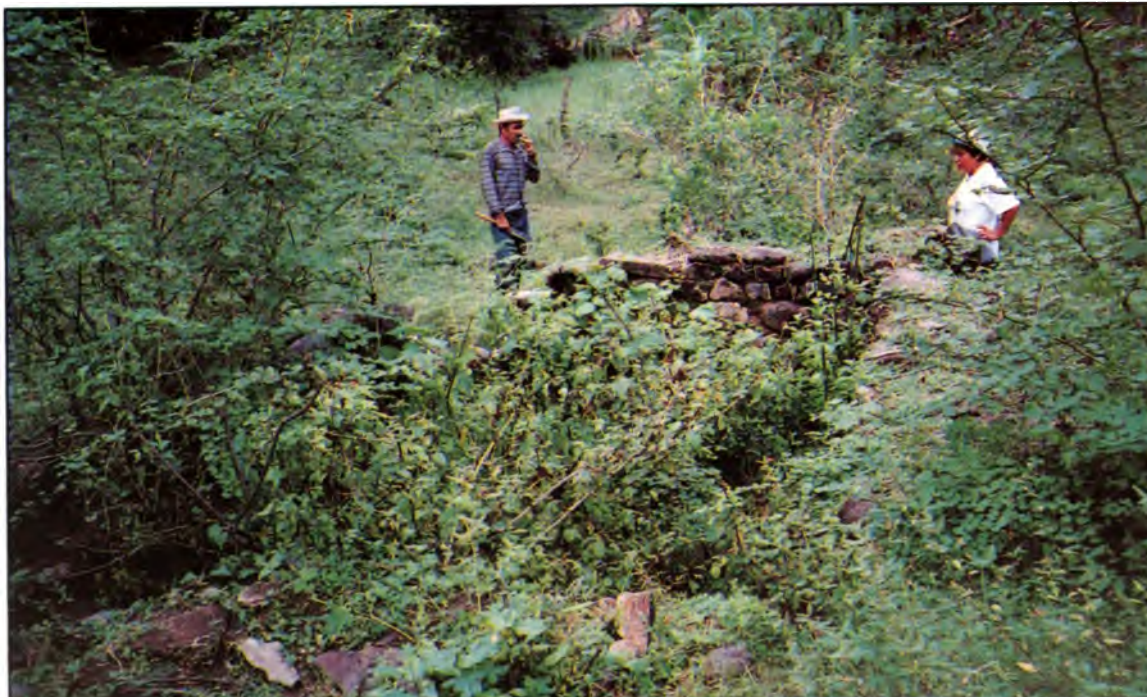
Obraje cubierto de vegetación que se puede reacondicionar para que vuelva a operar.
