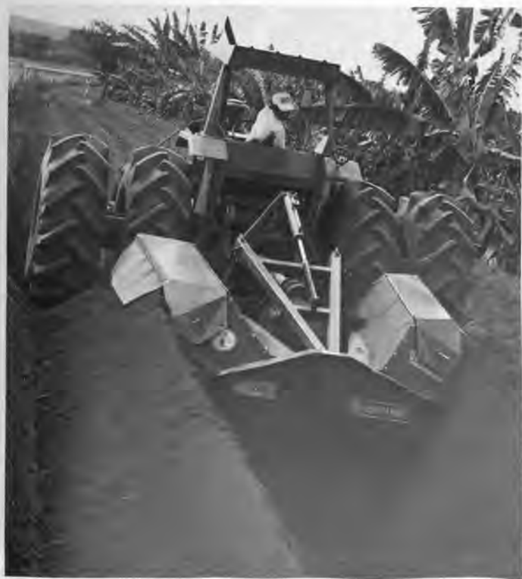
Equipamento para abertura de canais de irrigação, introduzido pelo IICA no Brasil.
